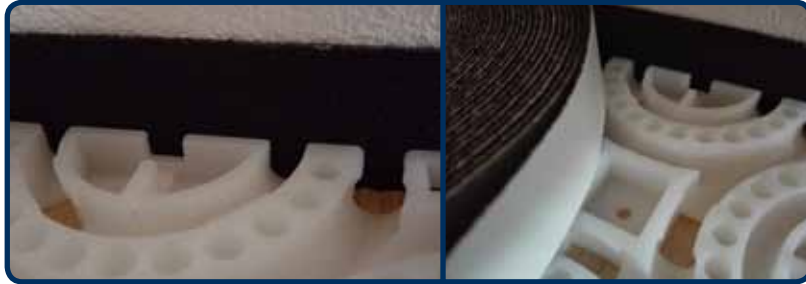
Randisolatie koud op de vloer / wand plakken, vlakke zijde "Click & Go" element tegen de randisolatie.
