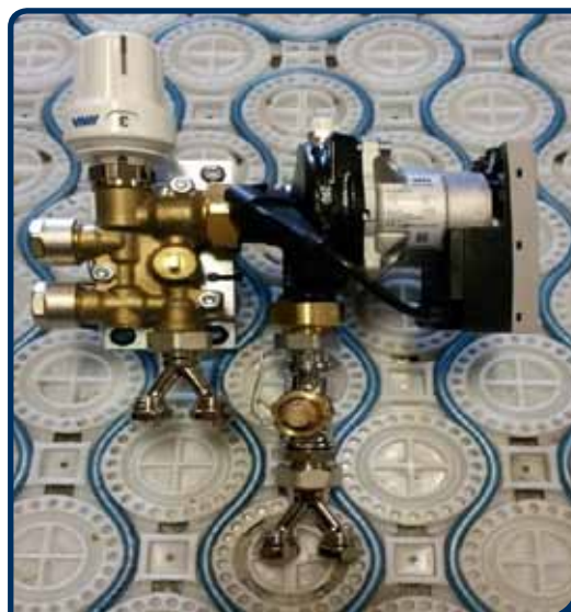
De montage van de Click 2 x 8 mm verbinding optimaal in een keer gereed.
