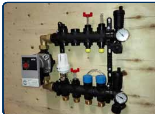
Volledig kunststofverdeler inclusief pompset thermostatische regeling max 20 groepen "Click en Go".
