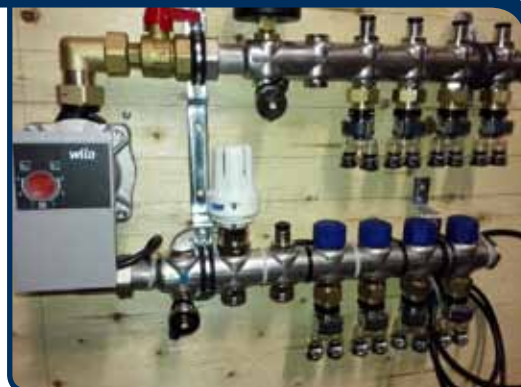
RVS Verdeler tot max 20 groepen "Click & Go" systeem met een energiezuinige circulatie Label A-pomp.
